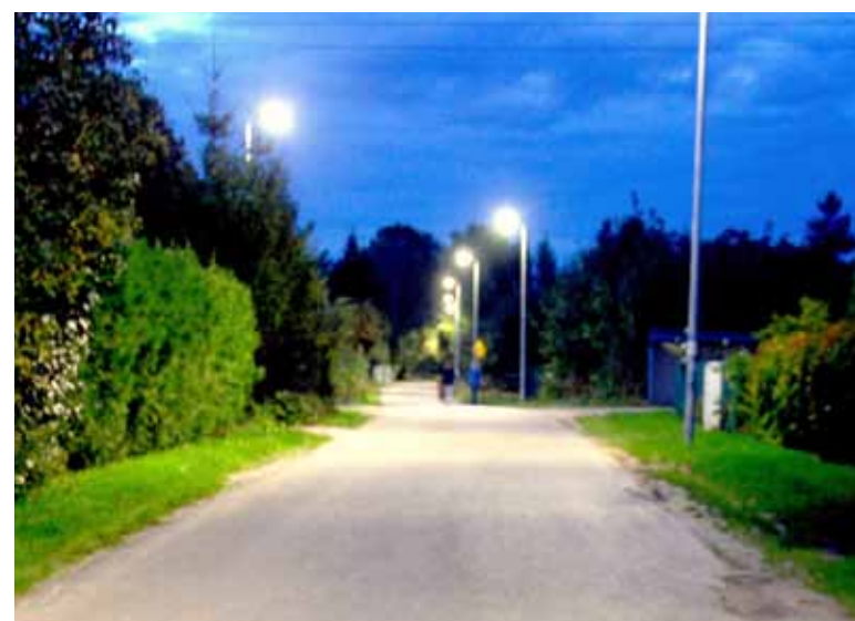
Na budowę oświetlenia w Smugach wydano kwotę 297 660,00 zł
